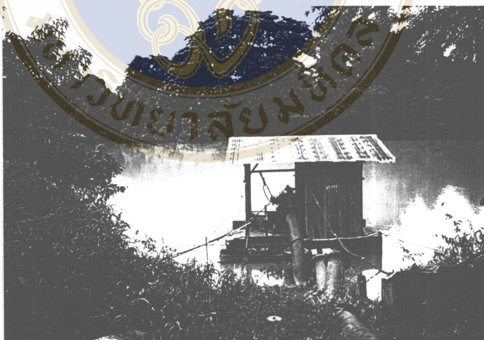
ภาพที่ 5 ปัมป์สูบน้ำชนิดเพเหมาะที่จะใช้กับสถานีที่มีปริมาณน้ำขึ้นลงมาก
