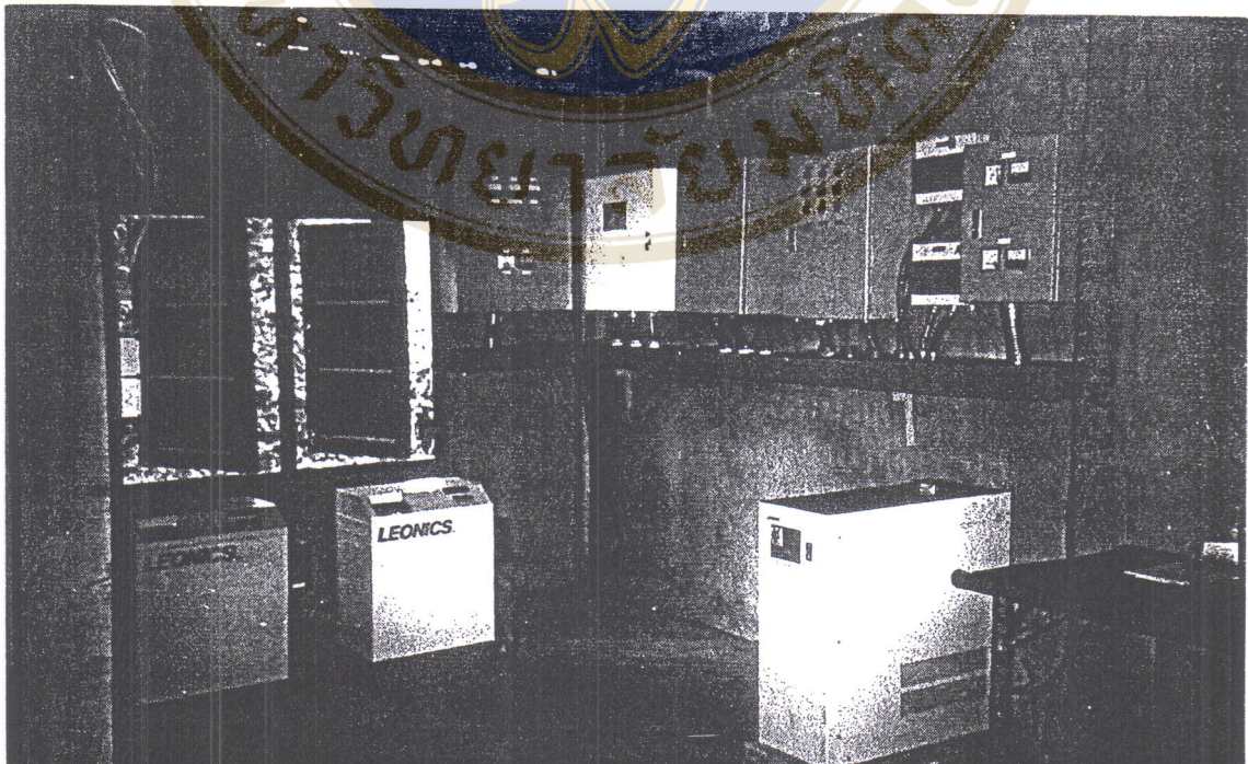
รูป 2-27 อินเวอร์เตอร์และชุดประจุแบตเตอรี่จากดีเซลเจนเนอเรเตอร์
