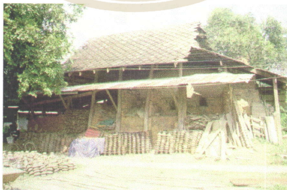
ภาพที่ 2-15 แสดงลักษณะเตาเผาก่อด้วยอิฐแบบจีน(เตาแมลงป่อง) ของนายทองหล่อ จิวออก
