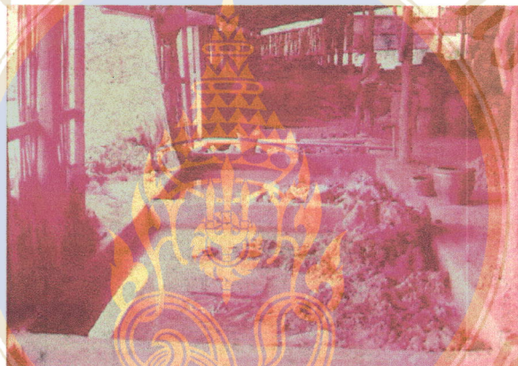
รูปภาพที่ 2-1 แสดงบ่อปูนที่สร้างขึ้นใช้สำหรับการหมักดิน
