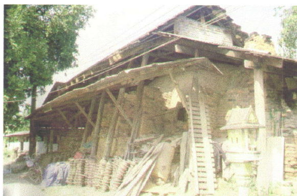
ภาพที่ 2-16 แสดงลักษณะเตาเผาที่ให้ความร้อนสูงช่วงปลายมีปล่องระบายลม
