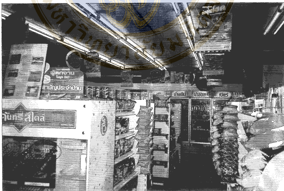
ภาพที่ 5.2 การติดตั้งดวงโคมประเภทโคมเปลือย 2 หลอดคู่
