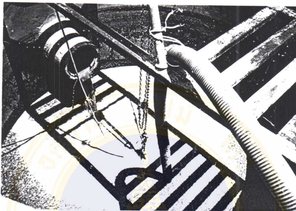
รูปที่ 3 บ่อรวมน้ำเสียจากคอกสุกร ภายในมีปั๊มน้ำสูบน้ำเข้าใส่บ่อเติมมูล
