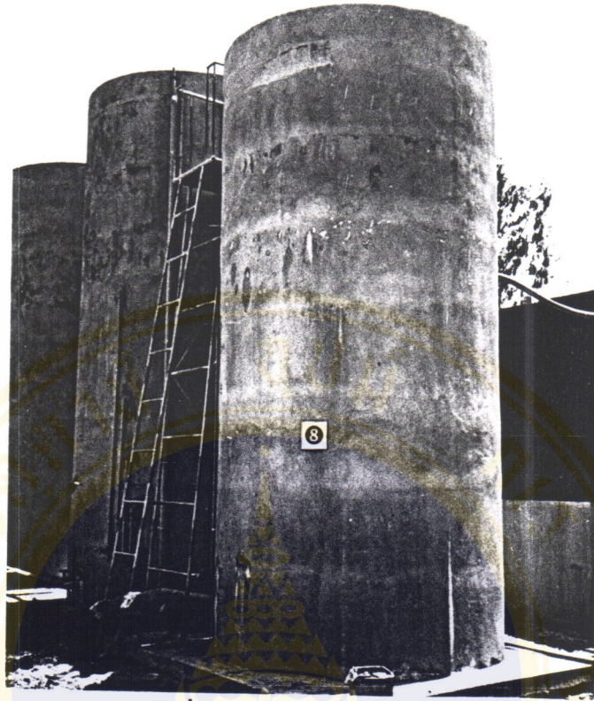
รูปที่ 7 บ่อหมักเร็วแบบUASB
