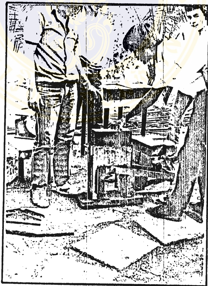
รูปที่ 4-27 การตัดอิฐอัดออกจากเครื่อง CINVA RAM
