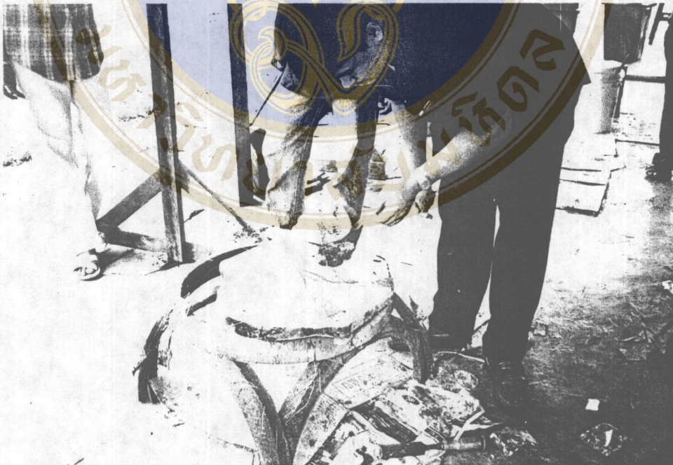
รูปที่ 4-8 ทำต้นแบบพลาสติกเสริมแรงด้วยใยแก้ว ส่วนคอห่านจากต้นแบบเซรามิกส์
