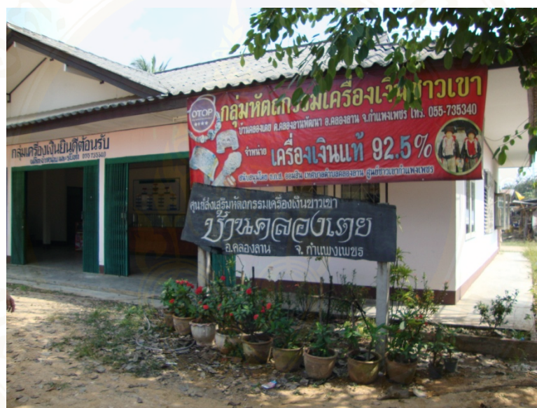
ภาพที่ 4.12 ศูนย์ส่งเสริมหัตถกรรมเครื่องเงินชาวเขา บ้านคลองเตย
