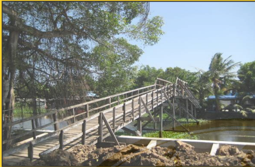
รูปที่ 38 ภาพสะพาน
